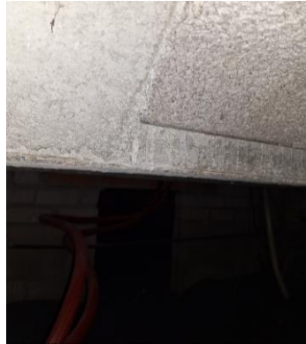
Foto 3a en b: Kruipruimte met bodemisolatie
