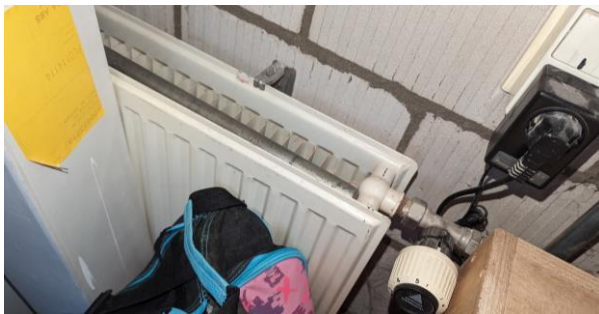
Foto 2: Paneelradiatoren
